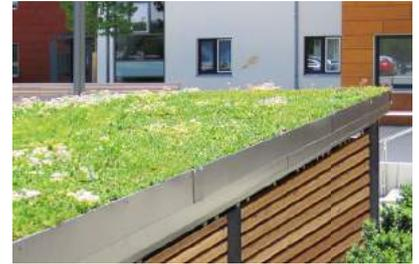
Natürliches Element im urbanen Raum, gepaart mit Vorteilen wie Lärmschutz und Regenwasserrückhalt. 40 mm hoch.
